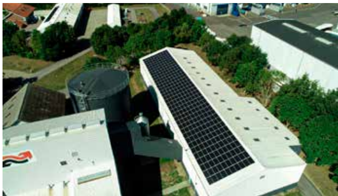
Fig. 3 - Midtjællælands Fjernvarmeværk in Rudkøbing (district heating) 110 kW PV plant (Photo: KlimaEnergi A/S).
