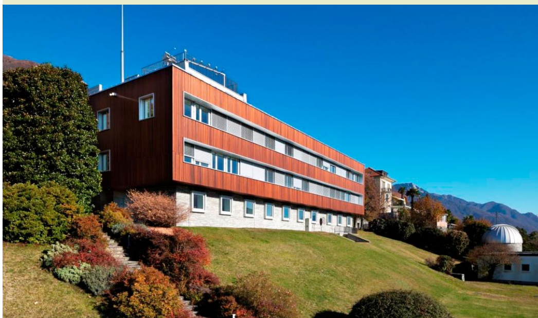
Das Gebäude von MeteoSchweiz in Locarno Monti wurde 2012 saniert. Die bisherige Ölheizung und Kühlgeräte wurden durch eine Wärmepumpenanlage mit Erdsonden ersetzt. Weiter wurde eine Photovoltaikanlage mit einer Leistung von 20 kWp installiert.
