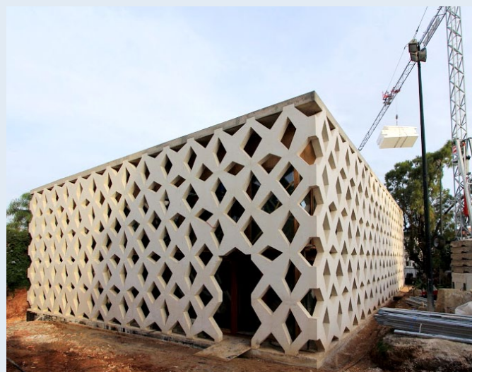
Neues Kanzleigebäude in Algier, Algerien. Die weisse Betonfassade ist speziell erdbebensicher und schützt die dahinter liegende Gebäudehülle vor der Sonne.
