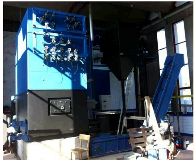
Die neue Holzschnitzelheizung in Changins.
