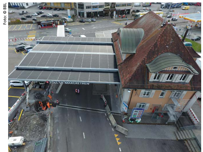
Die neue Fahrbahnüberdachung mit integrierter Photovoltaikanlage beim Zoll in St. Margrethen
