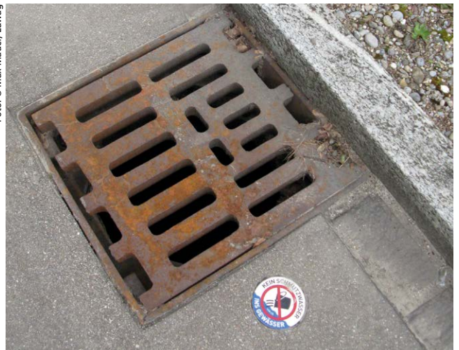
Hier warnt die Plakette nahe beim Gully davor, dass der Schacht in einen Bach, einen See oder ins Grundwasser führt.
