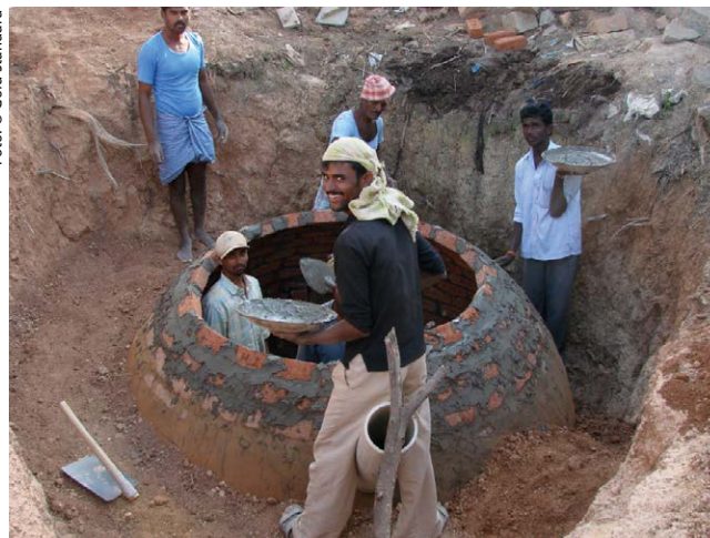
Bau einer kleinen Biogasanlage in einem der ausgewählten Kompensationsprojekte
