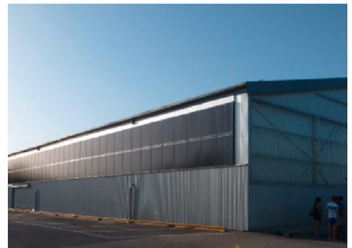
Photovoltaik-Module können auch in die Fassaden eingebaut werden wie hier bei der Kunsteisbahn in Romont. Quelle: Marcel Gutschner
