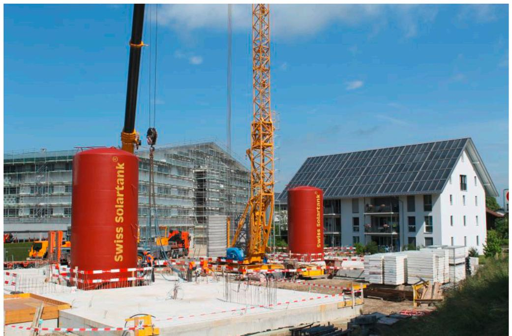
Neubauten, die zu 100 % mit Sonnenenergie geheizt werden. Die Warmwasserspeicher werden zu Beginn der Arbeiten aufgestellt. Quelle: Jenni Energietechnik
