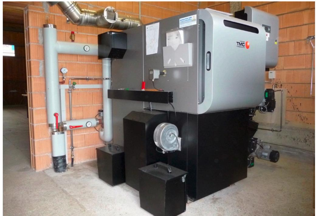
Heizkessel, der Wärme für mehrere Gebäude im Weiler Litzistorf (Bösingen) produziert. Quelle: Marcel Gutschner
