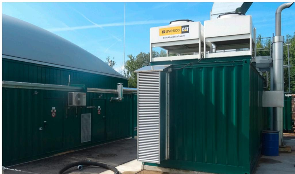
WKK-Anlage mit einer elektrischen Leistung von 150 kW am Standort der Biogasanlage der Firma Kompostieranlage Seeland AG auf dem Gebiet der Gemeinde Galmiz. Die Anlage verwertet das aus etwa 4500 Tonnen Grünabfällen gewonnene Methan und wandelt es in etwa 760 MWh Strom und 730 MWh Wärme um. Quelle: Marcel Gutschner
