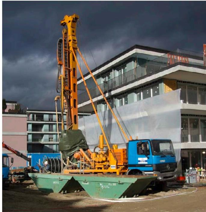
Bohrung für eine Erdwärmesonde. Quelle: GEOTHERMIE.CH
