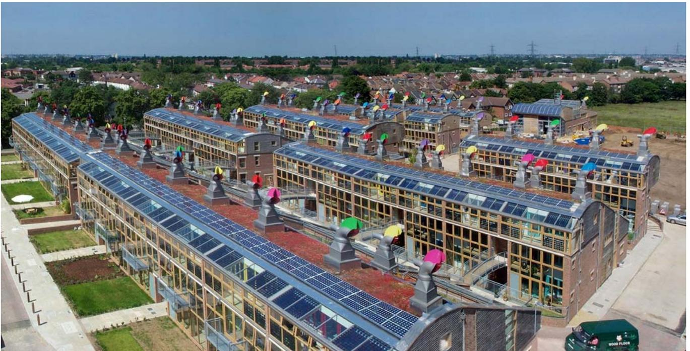
Abbildung 40: **Wohnen und Arbeiten in solaren Appartements in Beddington (GB).** Nullfossilenergiehäuser für Wohnen und Arbeiten in Einem. Die Siedlung mit einer ersten Tranche von 82 Einheiten baut auf ein innovatives Energie-
