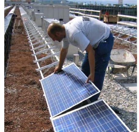
Abbildungen 61 bis 63: **Montage in Pfäffikon (SZ)**. Die Installation der Photovoltaikanlage (32 kW) auf dem Grünflachdach des Mehrfamilienhauses Huob der
