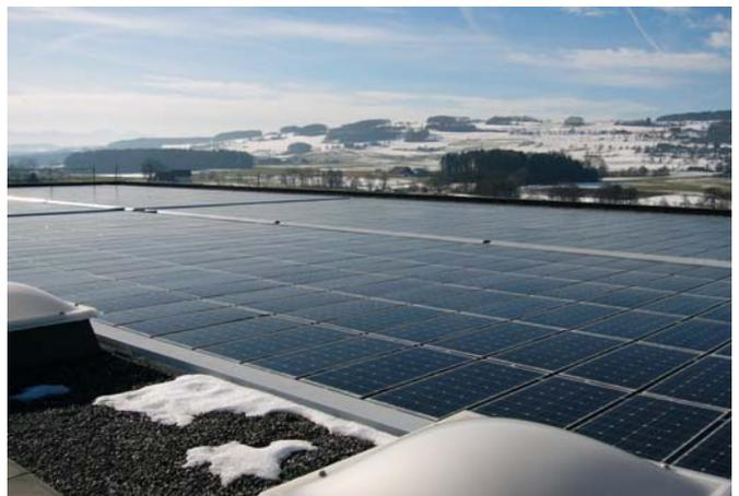
Abbildungen 66 und 67: **Solardachplatten**. Solardachplatten auf dem Hochregallager der Trisa in Triengen (LU). Auf dem Flachdach werden in Form eines Umkehrdaches Solardachplatten verlegt, welche aus einer Isolationsschicht
