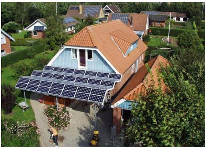
Abbildungen 104 und 105: **Standard Photovoltaikanlagen für bestehende Wohngebäude in Dänemark.** Das Sol-300 Programm setzt bewusst auf Standard Anlagen, um die Photovoltaiksysteme kostenoptimiert für bestehende
