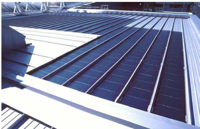
Thermoplast-Kunststoffdichtungsbahn dauerhaft und wasserdicht verschweisst. Eurodach (Beispiel in Flums) heisst die Verbindung von Metallfalzdach und Steinwolle-Wärmedämmung, die sich neu mit Solarelementen kombinieren lässt. Quelle: Sarnafil, Sarnen / NET, St. Ursen
