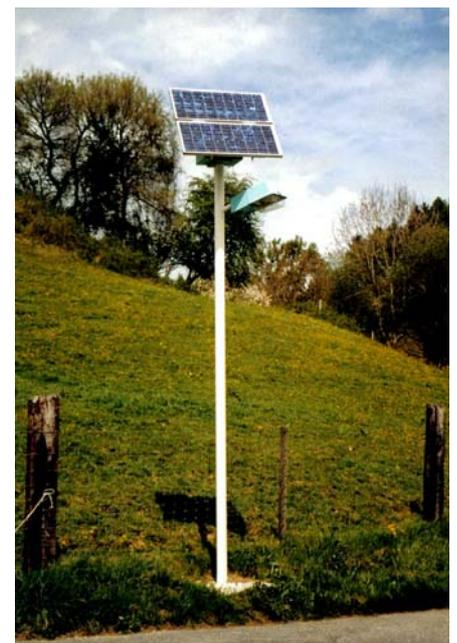
Abbildungen 4 und 5: **Fahrkartenautomaten.** Die Genfer und Freiburger Verkehrsbetriebe setzen solar betriebene Billettautomaten ein. Die Nahaufnahme des Solarmoduls: Dank der Neigung läuft das Wasser (und der Schnee) gut ab und reinigt gleichzeitig die Oberfläche. Quelle: M. Gutschner, Freiburg i.Ue
