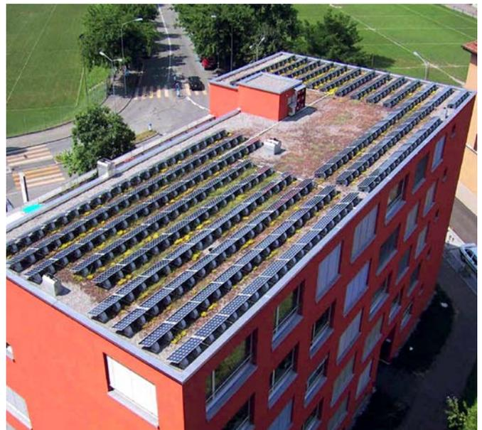
Abbildung 125: **Aufgeständerte Gründachlösung in Zürich.** Solgreen Montagestruktur erlaubt eine angepasste Lösung (Abstand zur Dachfläche, Fixierung der Unterkonstruktion auf dem Dach) auf dem Gebäude der Zürcher Wohn- und Baugenossenschaft. Quelle: NET, St. Ursen
