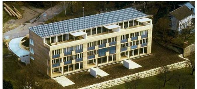
Abbildung 38: **Photovoltaik für Nullheizenergiehaus in Zürich Hängg.** Das Mehrfamilienhaus ist ein Nullheizenergiehaus: Der Solarstrom versorgt Wärmepumpe für Warmwasser und Heizung. Quelle: Beat Kämpfen, René Naef, Zürich
