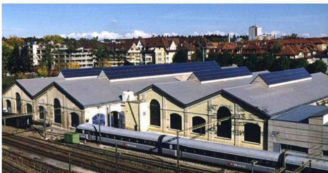
Abbildungen 78 und 79: **Solarstromanlagen in Bern.** Oberlicht-integrierte Anlage auf dem Lokomotivdepot und Sheddach-integrierte Anlage des Gewerbeparks Felsenau produzieren jährlich rund 50'000 respektive 225'000 kWh
