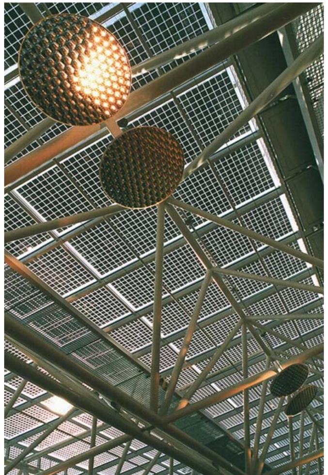
Abbildung 36: **Einkaufszentrum in Zürich.** Das Glasdach der Vorhalle mit Isolierglas-integrierter Solaranlage (30 kW) liefert Strom für das Elektrizitätswerk der Stadt Zürich (ewz). Quelle: energiebüro Zürich
