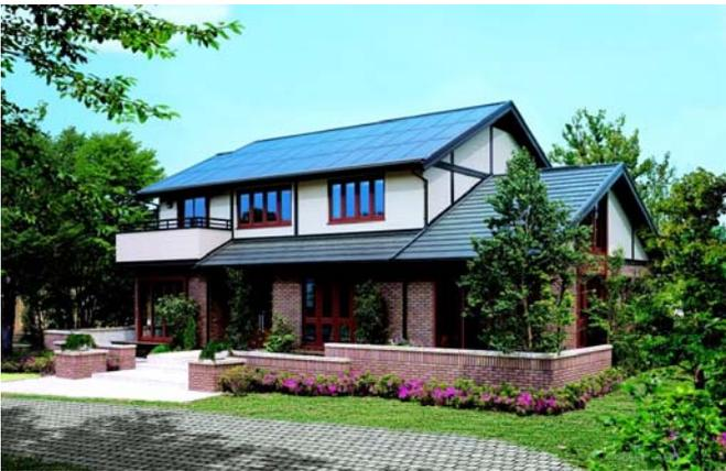
Abbildung 122: **Vollflächige Indachlösung.** Sekisui Heim ist ein japanisches Fertighaus, das für einen Aufpreis von CHF 21'000 eine 4 kW Photovoltaikanlage plus hocheffizientes Warmwassersystem mit einschliesst. Quelle: Sekisui, Japan
