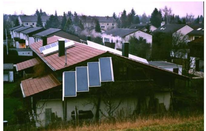
Abbildung 127: *“Integration” – kritisches Beispiel aus Krailling (D).* Das gute gemeinte Engagement der HausbewohnerInnen ist spürbar. Dennoch stellt sich die Frage, ob die Kollektoren und Module nicht ästhetischer integriert werden können. Rechtfertigt der energetische Mehrertrag durch erhöhte Neigung der solaraktiven Flächen diese Aufständigkeit? Quelle: M. Gutschner, Freiburg i.Ue.
