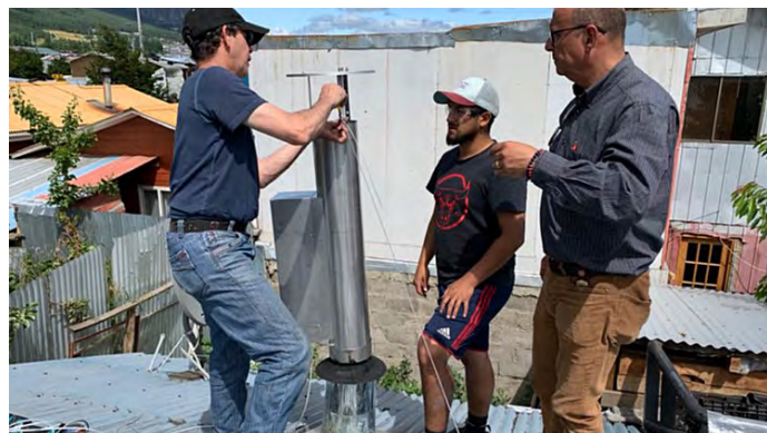
© Belmont Energie Raum
