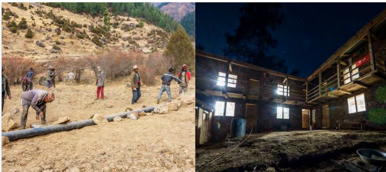
Figure 3: Chantier et bâtiment des machines de la pico-centrale de 6,6 kW à Mohari (© RIDS-Switzerland).
