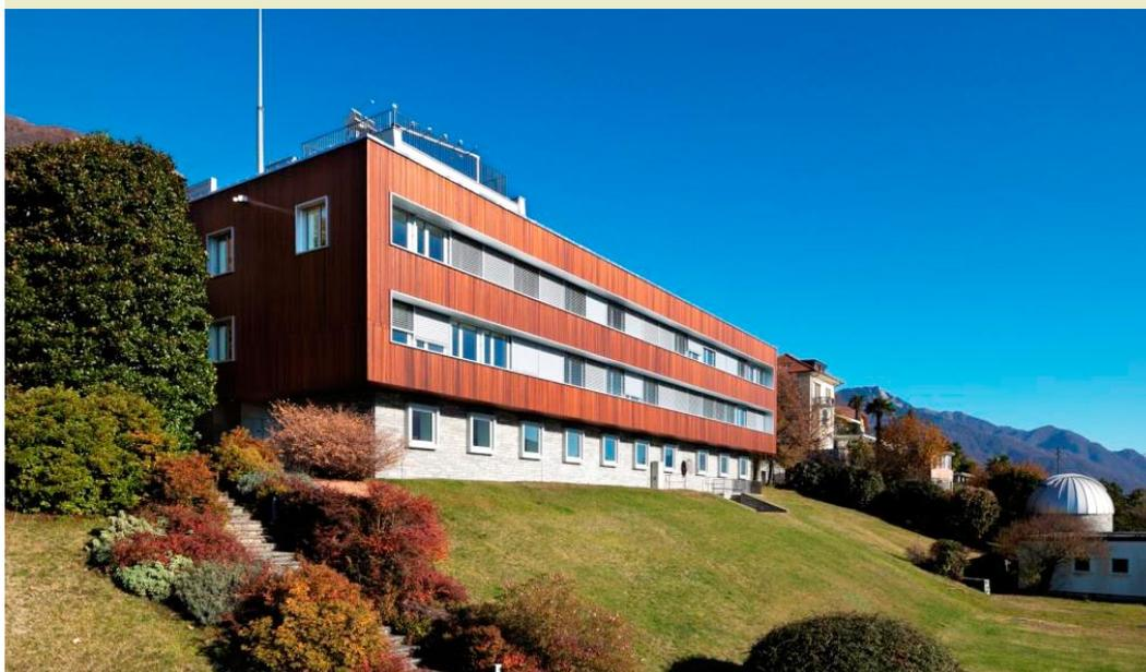
Le bâtiment de MétéoSuisse à Locarno Monti a été rénové en 2012. Le chauffage à mazout et la climatisation ont été remplacés par des pompes à chaleur avec sondes géothermiques. Une installation photovoltaïque d'une puissance de 20 kWp a également été installée.
