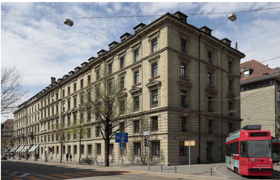
Immeubles assainis de la Bundesgasse 32 à 38
