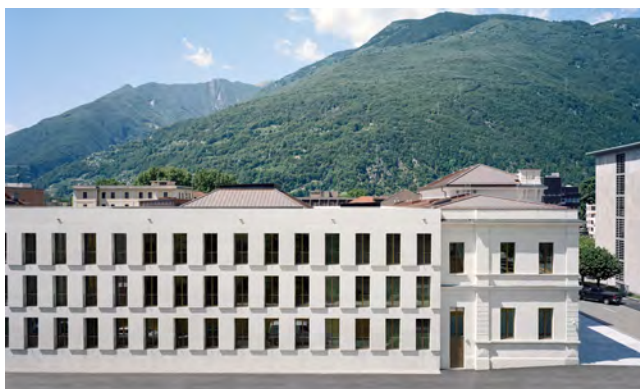
Nouveau Tribunal administratif fédéral à Bellinzona. A droite, l'ancienne partie sous protection historique, à gauche le nouveau bâtiment
