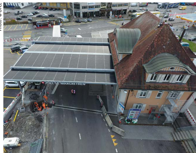
Le nouveau toit au poste de douane de St. Margrethen intégrant une installation photovoltaïque
