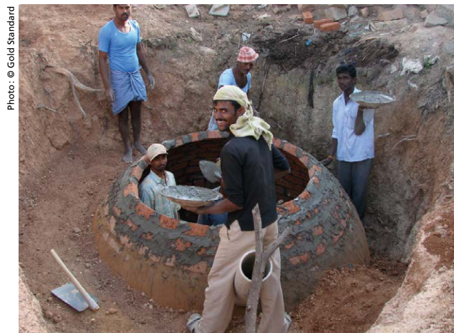
Construction d'une petite installation de biogaz dans le cadre de l'un des projets de compensation retenus
