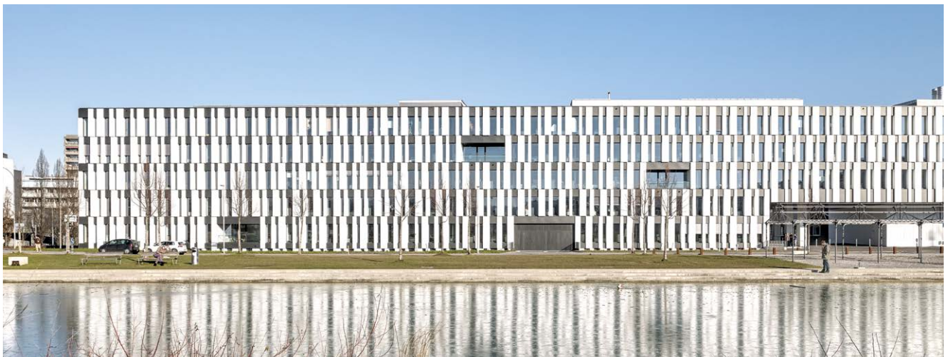
Le nouveau bâtiment de l'Office fédéral de la santé publique à Liebefeld
