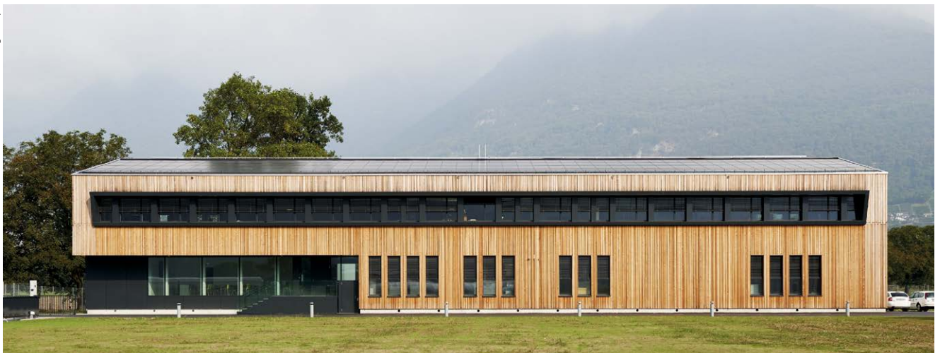
Le bâtiment principal du campus d'Agroscope à Cadenazzo est une construction en bois conforme aux normes Minergie-P-ECO et Minergie-A-ECO.
