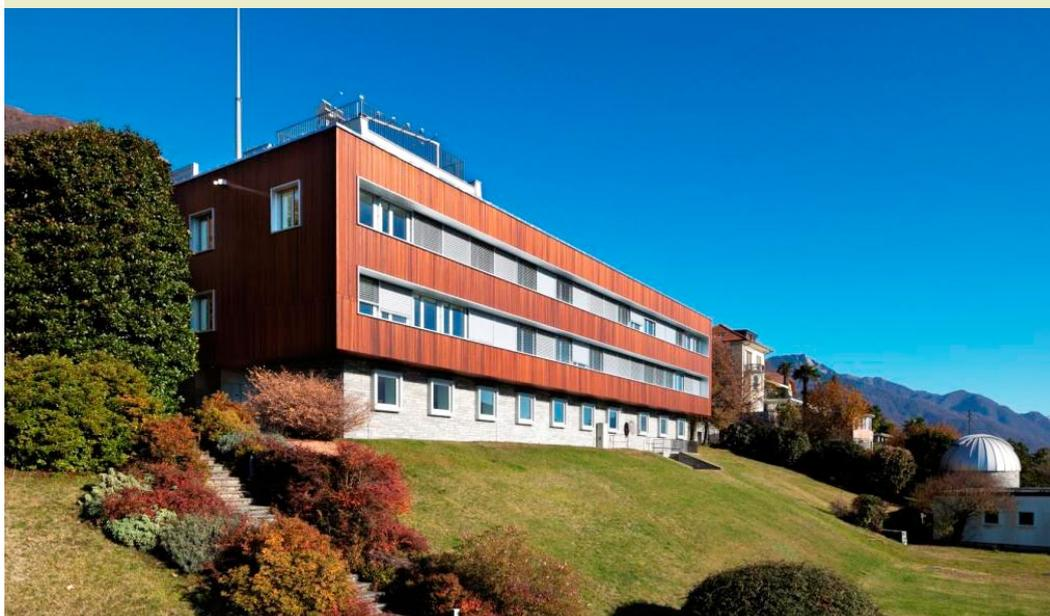
Das Gebäude von MeteoSchweiz in Locarno Monti wurde 2012 saniert. Die bisherige Ölheizung und Kühlgeräte wurden durch eine Wärmepumpenanlage mit Erdsonden ersetzt. Weiter wurde eine Photovoltaikanlage mit einer Leistung von 20 kWp installiert.
