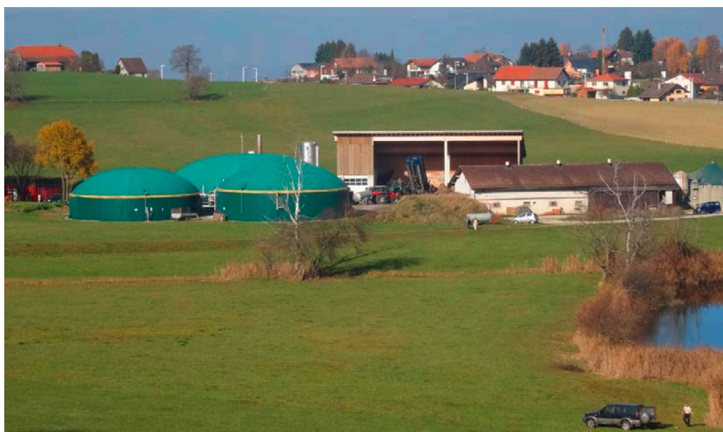
Die WKK-Anlage in Le Mouret auf dem Gemeindegebiet von Ferpicloz verfügt über eine elektrische Leistung von 280 kW und eine Wärmeleistung von 344 kW. Sie produziert etwa 2,1 GWh Strom und 2,6 GWh Wärme pro Jahr. Die mit Biogas betriebene Anlage nutzt Gülle und Mist aus rund zwanzig Landwirtschaftsbetrieben aus der Umgebung sowie organische Abfälle der Gemeinde. Quelle: Marcel Gutschner
