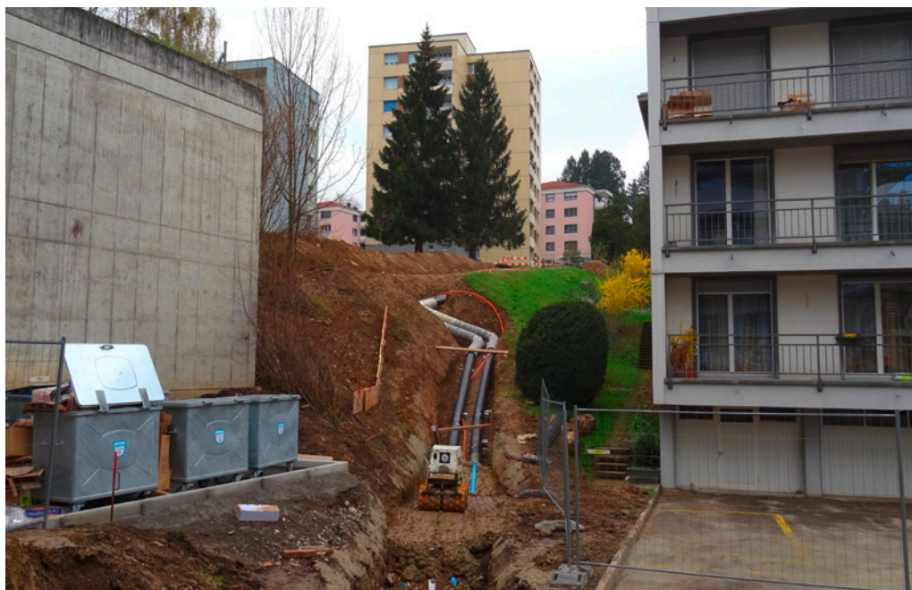
Einbau einer Fernwärme-Leitung im Jura-Quartier in Freiburg im April 2016. Quelle: Marcel Gutschner
