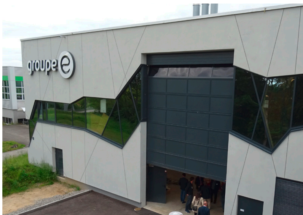
Fernheizzentrale in Dürdingen. Quelle: Marcel Gutschner
