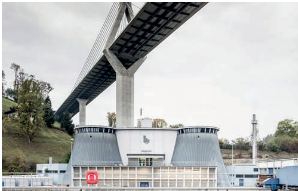
ARA-Biogasanlage der Stadt Freiburg. Quelle: Groupe E Celsius
