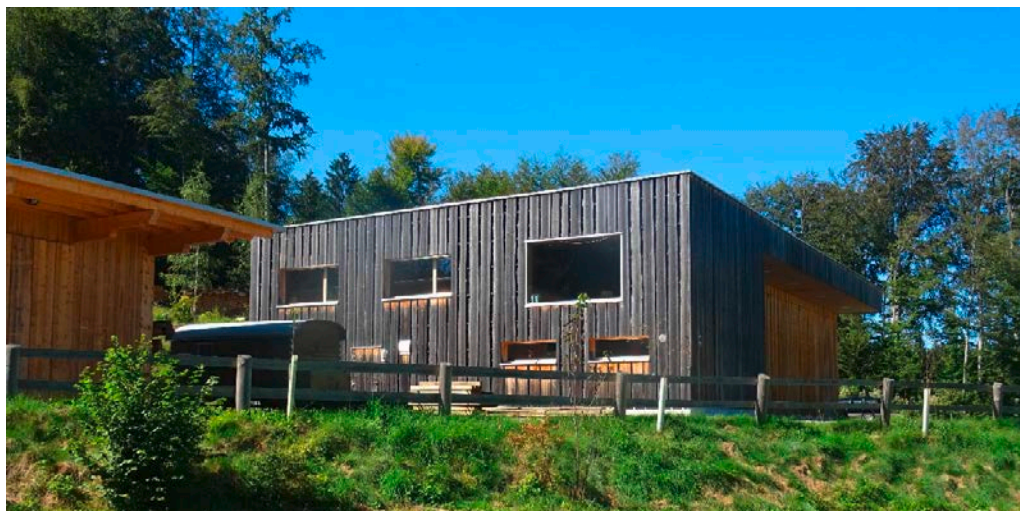
Betriebsgebäude des 2. Forstkreises in Rechthalten, Holzbau nach Minergie-P-ECO-Standard. Quelle: Marcel Gutschner
