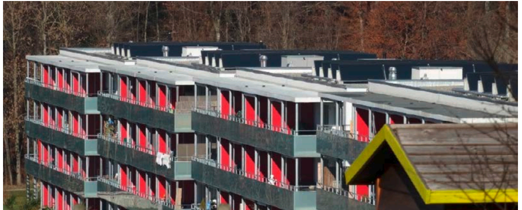
Mehrfamilienhäuser und thermische Solaranlagen – eine glückliche Kombination: hier eine Überbauung von vier Mehrfamilienhäusern in der Chännelmatte (Düdingen). Quelle: Marcel Gutschner
