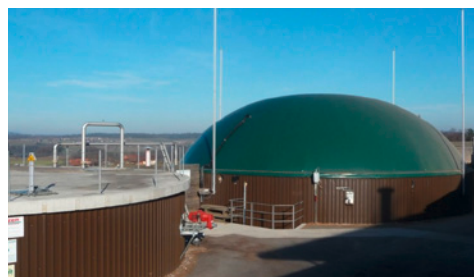
Das landwirtschaftliche Biogas wird in der Anlage in Uttewil (Bösingen) seit 1979 verwertet. Quelle: Marcel Gutschner
