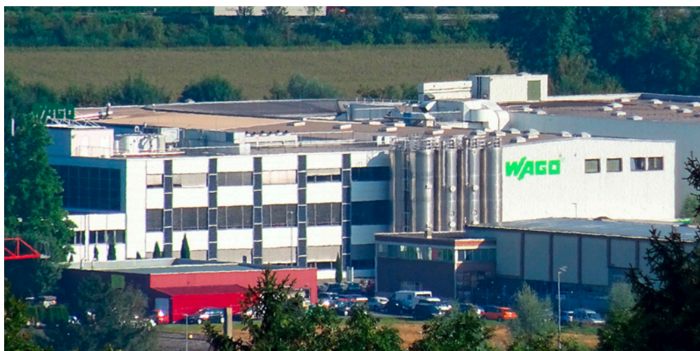
Das Unternehmen Wago hat zahlreiche Energieeffizienzmassnahmen bei den industriellen Verfahren an seinem Produktionsstandort in Domdidier getroffen [20]. Bei der Sanierung der Fassade wurde das Gebäude mit Solarmodulen ausgestattet. Quelle: Marcel Gutschner
