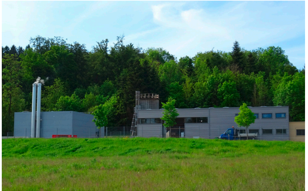
Fernheizzentrale in Corminboeuf mit einem Holzheizkessel von 900 kW, der mindestens 80 % der Wärmeproduktion sicherstellt, und einem Gasheizkessel von 1050 kW, der bei grosser Kälte eingesetzt wird, um die Spitzenlast zu bewältigen. Die beiden Gebäude (Fernheizzentrale und Werkhof) sind je mit einer Photovoltaikanlage von 17 bzw. 38 kW ausgestattet. Quelle: Marcel Gutschner
