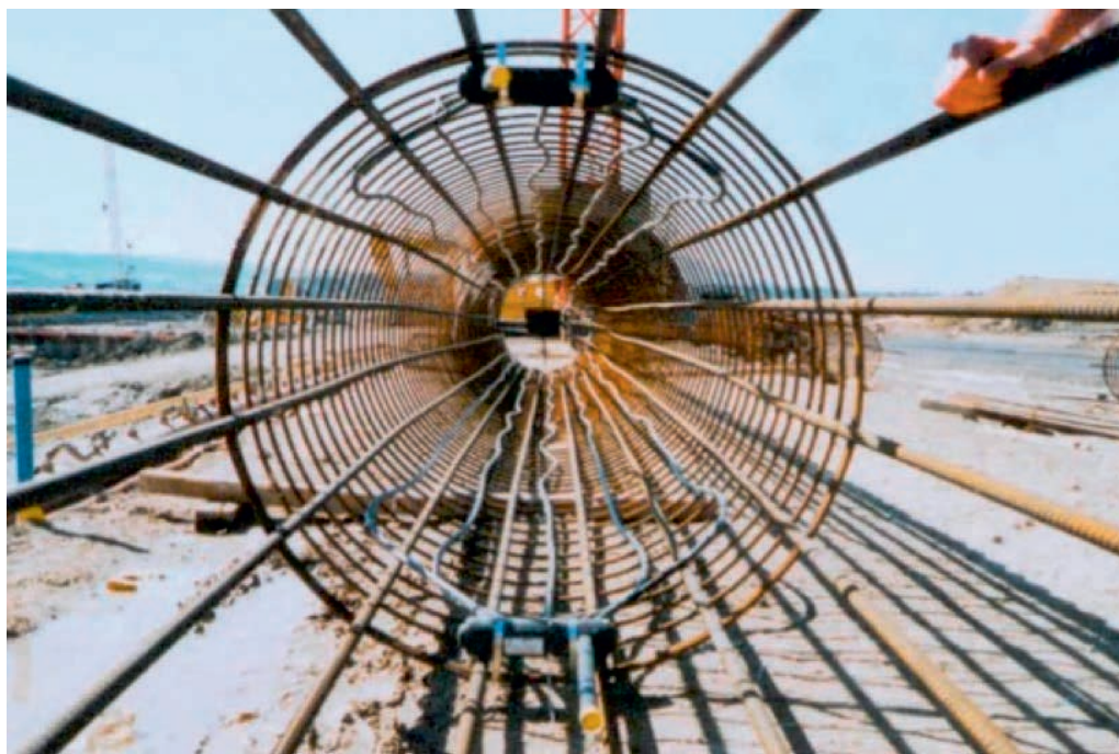
Rohrleitungen für die Zirkulation der Wärmeträgerflüssigkeit an einer Energiepfahl-Armierung. Quelle: [3]
