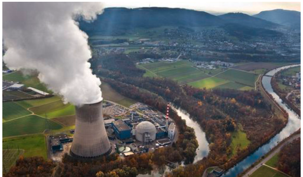
Kernkraftwerk Gösgen (SO)
