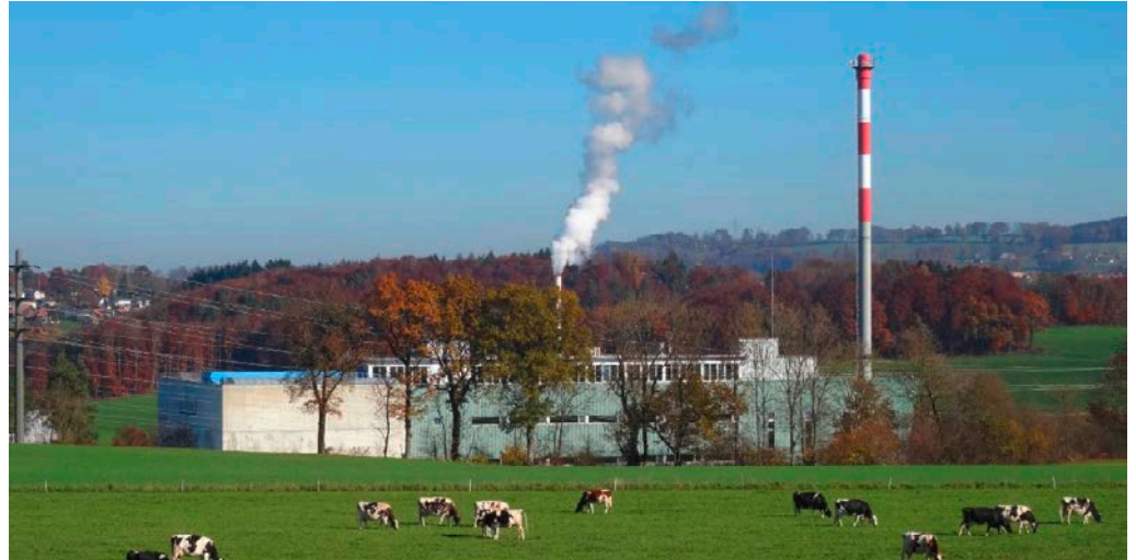
Kehrichtverbrennungsanlage der SAIDF. Quelle: Marcel Gutschnerr
