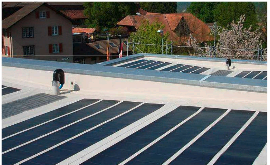
Dünnschichtzellen auf einem Kirchendach in Bödingen. Quelle: Sika Sarnafil
