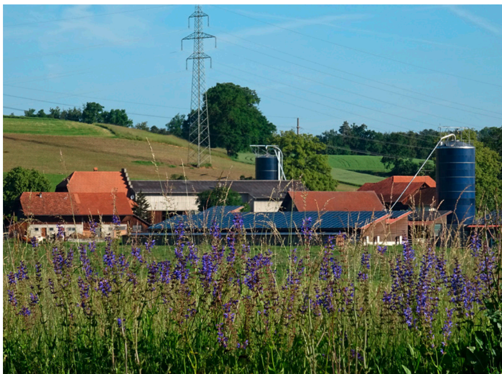
Photovoltaikanlagen beginnen sich in allen Regionen des Kantons Freiburg auszubreiten. Hier: Anlagen in Menziswil (Tafers). Quelle: Marcel Gutschner
