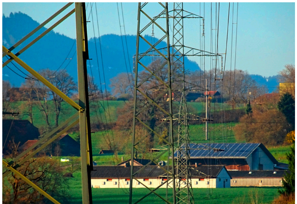
Das künftige Stromversorgungssystem muss die Zunahme der Stromerzeugung aus erneuerbaren Quellen berücksichtigen und sich auf ein intelligentes Netz abstützen, das für die dezentrale Stromproduktion gerüstet ist. Im Bild: Bauernhof in Römerswil (St. Ursen). Quelle: Marcel Gutschner
