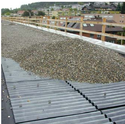
Abbildungen 61 bis 63: Montage in Pfäffikon (SZ). Die Installation der Photovoltaikanlage (32 kW) auf dem Grünflachdach des Mehrfamilienhauses Huob der
