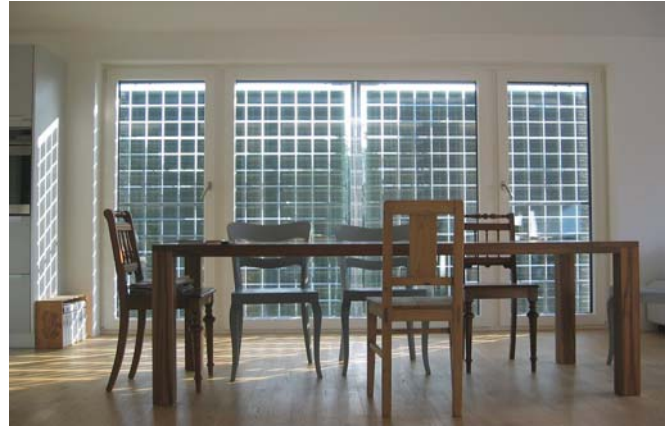
Einfamilienhauses weisen eine Gesamtleistung von 3,1 kW auf. Quelle: R. Miloni, Mülligen
