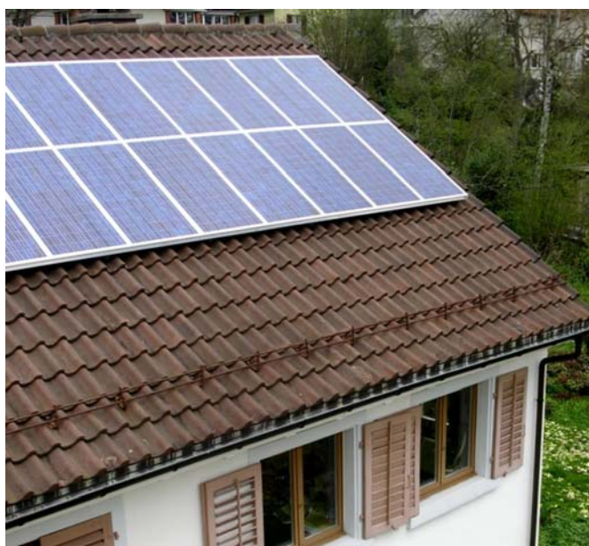
Abbildung 95: Photovoltaikanlage auf dem Schrägdach eines Einfamilienhauses in Zürich. Mit 3,3 kW hat die Installation eine typische Anlagengrösse der „Solaraktion“. Quelle : BE Netz, Luzern
