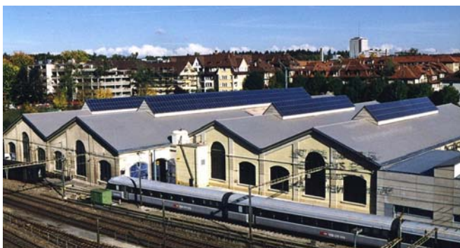
Abbildungen 78 und 79: Solarstromanlagen in Bern. Oberlicht-integrierte Anlage auf dem Lokomotivdepot und Sheddach-integrierte Anlage des Gewerbeparks Felsenau produzieren jährlich rund 50'000 respektive 225'000 kWh
