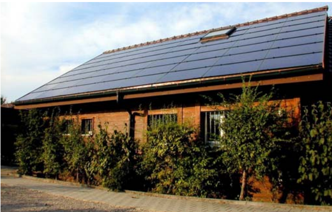
Abbildungen 30 und 31: Pfadiheim Weiermatt in Köniz (BE). Das Könizer Pfadiheim setzt auf Solarstrom. Im Bild links ist die vollflächige Photovoltaikanlage auf einem Trakt des Pfadiheims zu sehen. Das Bild rechts zeigt die Ansprache der Gemeinderätinnen während der Einweihungsfeier; im Hintergrund ist die teil-
