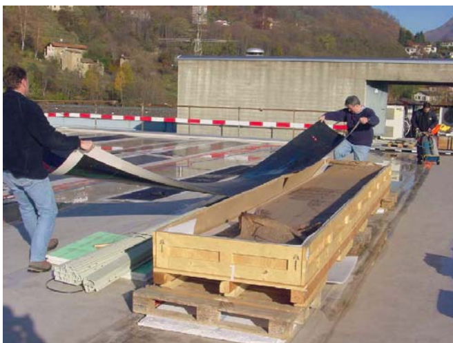
Abbildungen 64 und 65: Flexible Solarmembrane. Flexible Dachlaminatlösungen mit Photovoltaik. Das Anbringen von Solarmembranen erfolgt gemäss üblichen Standards und Techniken. Die Membranen werden aus der Transportkiste
