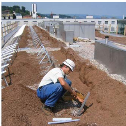
Abbildungen 61 bis 63: Montage in Pfäffikon (SZ). Die Installation der Photovoltaikanlage (32 kW) auf dem Grünflachdach des Mehrfamilienhauses Huob der
