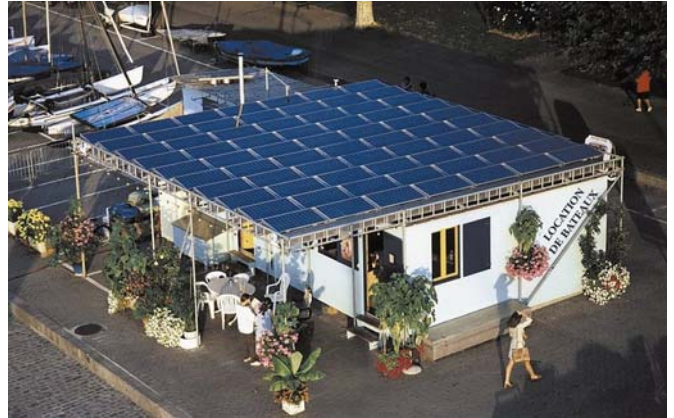
Abbildung 29: La Rade Solaire in Genf. Die Anlage „Les Corsaires“ gehört zur Rade Solaire, die entlang des städtischen Seeufers verschiedene photovoltaische Anwendungen zeigt. Die abgebildete Anlage speist mehrere Solarboote sowie eine solarbetriebene Touristenbahn. Quelle: ScanE, Genf
