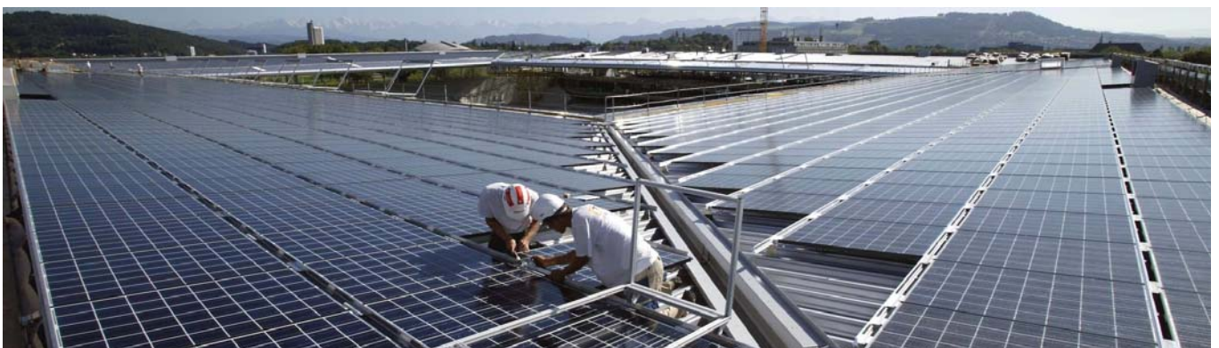
Abbildung 27: Stade de Suisse in Bern . Die Solaranlage deckt auf Jahresbasis den Strombedarf von 200 Schweizer Haushalten. Quelle: BKW
