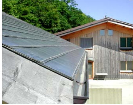
Abbildungen 7 bis 9: Hütten und Betriebe. Alpgastwirtschaft Auta Chia (FR), autonome Solarstromanlage (3 kW) auf Nebengebäude der Bioweinproduktion
