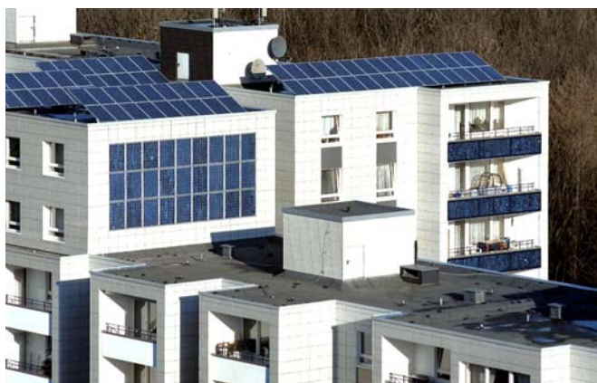
Abbildungen 41 und 42: 50 Solarsiedlungen in Nordrhein-Westfalen (D). In Nordrhein-Westfalen (NRW) entstehen in den nächsten Jahren 50 Solarsiedlungen, die sich durch eine intensive aktive und passive Nutzung der Solarenergie auszeichnen. Das Projekt wird von drei Landesministerien (Städtebau und Wohnen,
