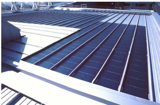
Thermoplast-Kunststoffdichtungsbahn dauerhaft und wasserdicht verschweisst. Eurodach (Beispiel in Flums) heisst die Verbindung von Metallfalzdach und Steinwolle-Wärmedämmung, die sich neu mit Solarelementen kombinieren lässt. Quelle: Sarnafil, Sarnen / NET, St. Ursen
