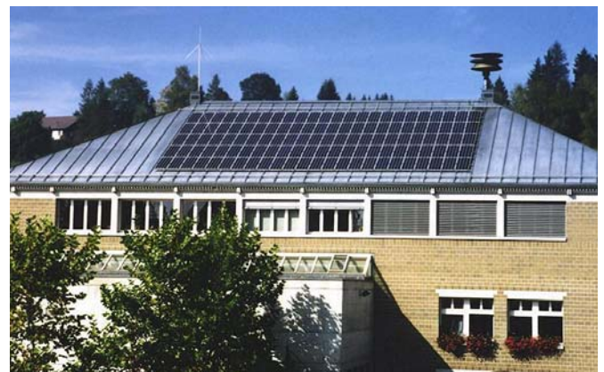
Abbildung 133: Dank Gönner Solaranlage auf dem Gemeindezentrum in Rehetobel (AR). Ein Gönner hatte den Wunsch, in seiner Wohngemeinde etwas Bleibendes für die Umwelt zu schaffen. Mit dem Einverständnis der Gemeinde beauftragte er eine Vereinigung, auf dem Dach des Gemeindezentrums eine Solaranlage zu installieren. Nach der Inbetriebnahme ging die Anlage in den Besitz der Gemeinde über. Die Vereinigung wartet die Anlage und ist dafür berechtigt, den erzeugten Strom im Rahmen ihres Ökostrom-Angebots zu verkaufen. Quelle: Appenzeller Energie - Vereinigung zur Förderung umweltfreundlicher Energien
