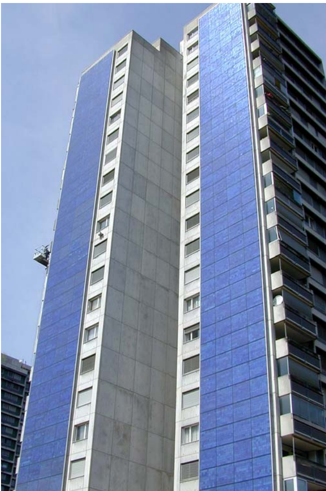
Abbildung 35: Europas größtes fassaden-integriertes Solarkraftwerk steht in Bern Wittigkofen. Mit einer Leistung von 80 kW produziert die Anlage Solarstrom für Energie Wasser Bern (ewb). Quelle: NET, St. Ursen
