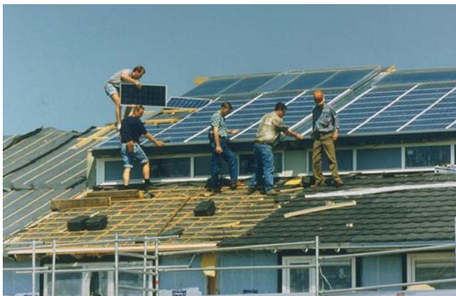
Abbildung 120: Einbau- oder Indachlösung. Quelle: Ecofys Niederlande
