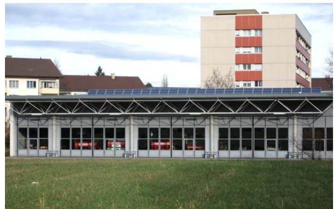
(finanziell) zu engagieren. In Köniz (BE) ist die Photovoltaikanlage eher diskret auf dem Flachdach angebracht. Quelle: Samyn & Partners / R. Schropp, Niederlande / M. Gutschner, Freiburg i.Ue.
