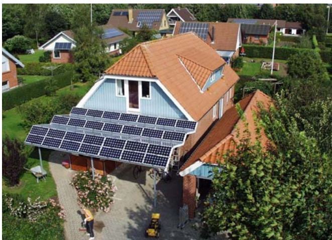
Abbildungen 104 und 105: Standard Photovoltaikanlagen für bestehende Wohngebäude in Dänemark. Das Sol-300 Programm setzt bewusst auf Standard Anlagen, um die Photovoltaiksysteme kostenoptimiert für bestehende
