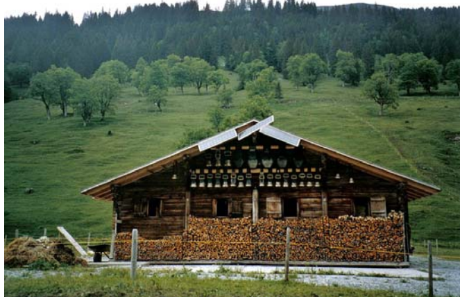
Abbildung 126: “Integration” – kritisches Beispiel aus dem Richenbachtal (BE). Die zierliche Hütte nahe Rosenloui (BE) zieht die Blicke vor allem wegen der Treicheln und dem urchigen Look an. Aber der zweite Blick stösst sich an der Art und Weise, wie das mittlere Modul angeordnet ist. Böte das Dach eine bessere Integration, ohne grossen Minderertrag zu erleiden? Würde eine symmetrische Anordnung mit einer geraden Anzahl Module an der Dachkante nicht harmonischer wirken? Quelle: M. Gutschner, Freiburg i.Ue.
