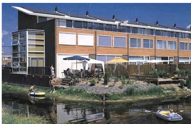
Abbildungen 43 bis 45: Solarer Siedlungsbau in Amersfoort (NL) . Mehrere hundert Gebäude (Einfamilienhäuser, Kindergarten, etc.) sind bei der Überbauung
