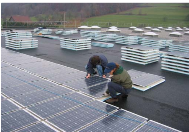
Abbildungen 66 und 67: Solardachplatten. Solardachplatten auf dem Hochregallager der Trisa in Triengen (LU). Auf dem Flachdach werden in Form eines Umkehrdaches Solardachplatten verlegt, welche aus einer Isolationsschicht
