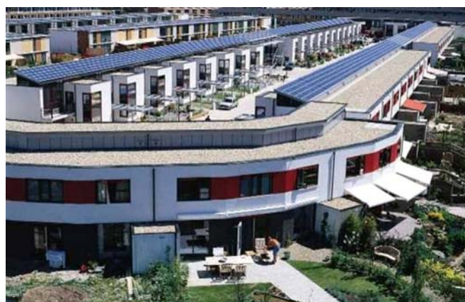
Nieuwland mit Photovoltaik ausgestattet. Dank integrierter Planung sind die diversen Anforderungen gut aufeinander abgestimmt. Quelle: Ecofys, Niederlande
