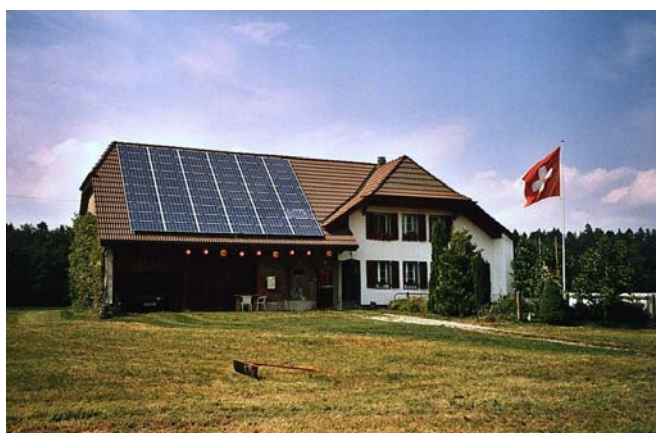
Abbildung 123: Teilflächige Aufdachlösung. Das Gebäude in Lyss (BE) beherbergt eine Anlage in Aufdachlösung – unterstützt im Rahmen des „Solarfrankens“ (CHF 1.00 pro solare kWh, garantiert während 10 Jahren) der ehem. Gemeindebetriebe Lyss. Quelle: M. Gutschner, Freiburg i. Ue.
