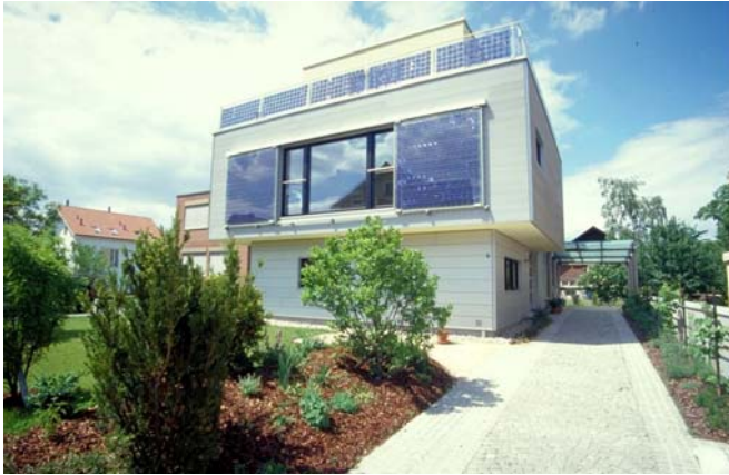
Abbildungen 59 und 60: Innovatives Design mit Passivhaustechnologie und Photovoltaik in Pratteln (BL). Aussen- und Innenansicht des Gebäudes mit solaren Fensterläden im Blickfeld. Die verschiedenen Photovoltaik Elemente des
