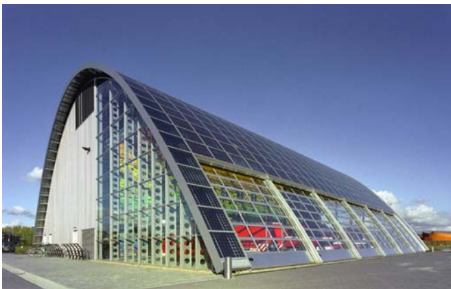
Abbildungen 117 und 118: Photovoltaik - mal auffällig, mal diskret. Feuerwehrdepots im Vergleich. Das auffällige Design der Feuerwehrrhalle im niederländischen Houten hat verschiedene Akteure dazu bewogen, sich beim Projekt
