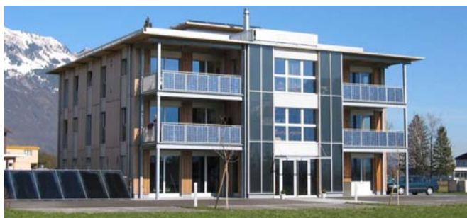
Abbildung 37: Minergie und Photovoltaik in Gams (SG). Das Büro- und Gewerbegebäude des Synergieparks ist mit Solarmodulen in der Balkonbrüstung und auf dem Dach ausgestattet. Quelle: Heizplan / Synergiepark
