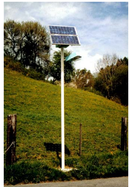
Abbildung 6: Autonome Strassenlampe. Licht ohne grossen Aufwand für Netzanschluss am Wohnensee (BE). Quelle: M. Gutschner, Freiburg i.Ue
