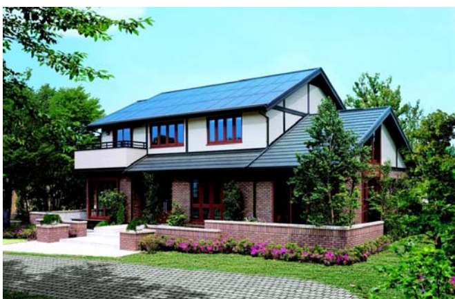
Abbildung 122: Vollflächige Indachlösung. Sekisui Heim ist ein japanisches Fertighaus, das für einen Aufpreis von CHF 21'000 eine 4 kW Photovoltaikanlage plus hocheffizientes Warmwassersystem mit einschliesst. Quelle: Sekisui, Japan
