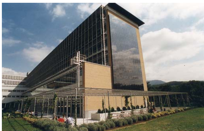
Abbildung 48: Bürogebäude in Manno (TI) mit Photovoltaik im Gesamtenergiekonzept. Der Neubau der UBS wurde in ökologischer und energetischer Hinsicht beispielhaft erstellt. Die Photovoltaikanlage umfasst 183 kW verteilt auf verschiedenen Flächen der Gebäudehülle: 102 kW auf dem Flachdach, 47 kW in der Dachbrüstung (auch als Sonnenschutz) und 34 kW in zwei Südfassaden. Quelle: Enecolo, Mönchaltorf
