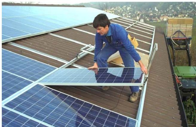
Abbildung 121: Aufbau- oder Aufdachlösung. Quelle : BE Netz, Luzern
