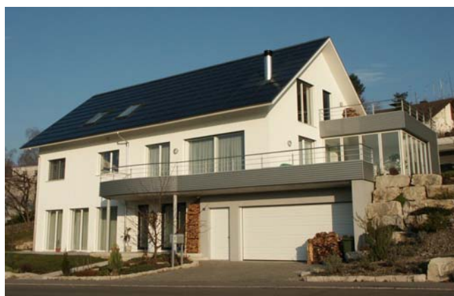
Abbildung 51: Einfamilienhaus in Untersiggenthal (AG) mit flächendeckender Photovoltaikanlage. Die Stromproduktion der Photovoltaikanlage liegt auf Jahresbasis rund 15% über dem gesamten Energiebedarf des Einfamilienhauses (inkl. Heizung und Warmwasser). Quelle: G. Erni, Untersiggenthal
