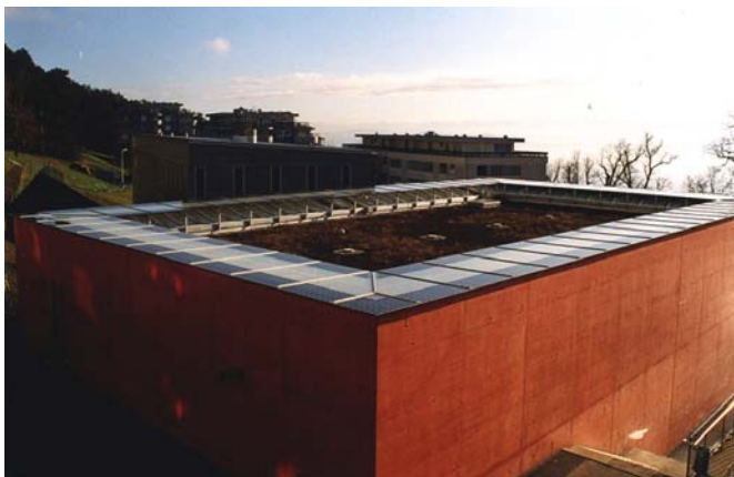
Abbildung 112: Minergie und Solarstrom in Neuenburg. Die Turnhalle der Schule Acacias im Minergiestandard hat eine multifunktionale Photovoltaikanlage von 69 m 2 Modulfläche auf ihrem Dach: sie erzeugt Strom und funktioniert zudem als Sonnenschutz. Quelle: Service de l'urbanisme de la ville de Neuchâtel
