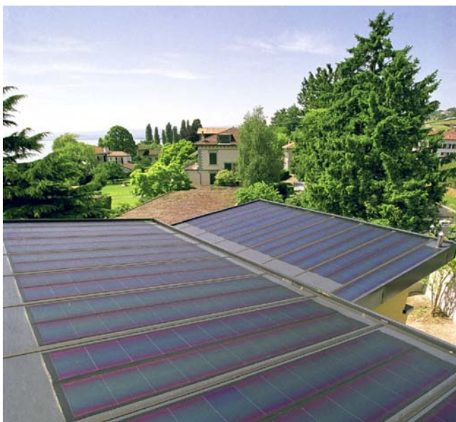
Abbildung 124: Dachintegration Freestyle mit Dünnschichtzellenmodulen in Lutry (VD). Das neue Einfamilienhaus wurde mit integrierten Dünnschichtzellenmodulen gebaut. Die Photovoltaikanlage (5,5 kW) ist vom Boden aus nicht erkennbar. Quelle: NET, St. Ursen
