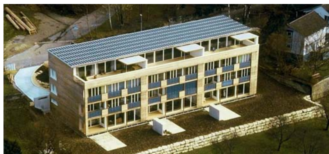
Abbildung 38: Photovoltaik für Nullheizenergiehaus in Zürich Hängg. Das Mehrfamilienhaus ist ein Nullheizenergiehaus: Der Solarstrom versorgt Wärmepumpe für Warmwasser und Heizung. Quelle: Beat Kämpfen, René Naef, Zürich
