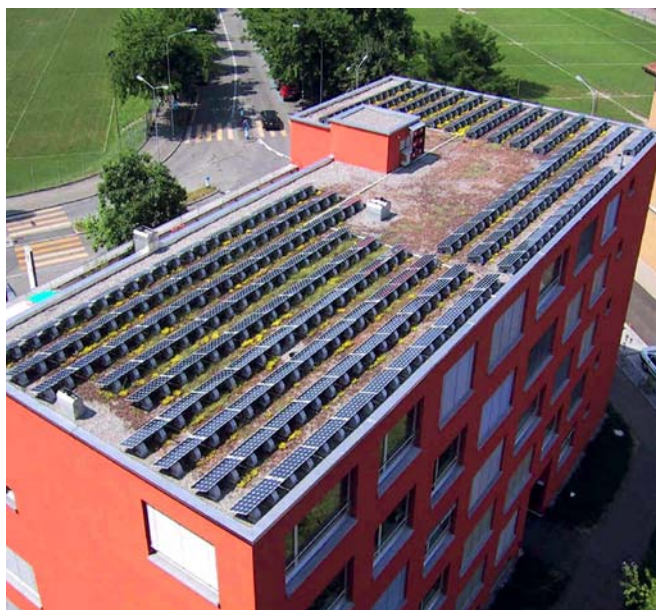
Abbildung 125: Aufgeständerte Gründachlösung in Zürich. Solgreen Montagestruktur erlaubt eine angepasste Lösung (Abstand zur Dachfläche, Fixierung der Unterkonstruktion auf dem Dach) auf dem Gebäude der Zürcher Wohn- und Baugenossenschaft. Quelle: NET, St. Ursen
