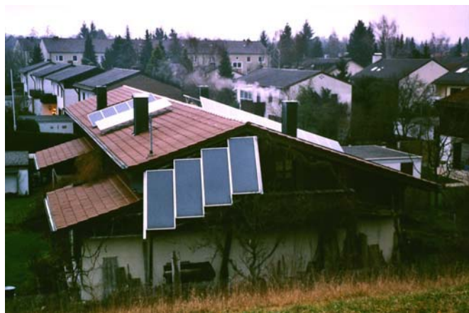
Abbildung 127: “Integration” – kritisches Beispiel aus Krailling (D). Das gute gemeinte Engagement der HausbewohnerInnen ist spürbar. Dennoch stellt sich die Frage, ob die Kollektoren und Module nicht ästhetischer integriert werden können. Rechtfertigt der energetische Mehrertrag durch erhöhte Neigung der solaraktiven Flächen diese Aufständerei? Quelle: M. Gutschner, Freiburg i.Ue.
