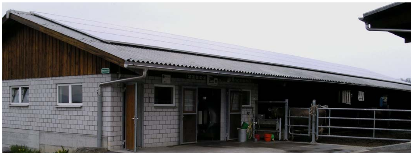
Abbildung 94: Photovoltaikanlage auf dem Laufstall in Zürich. Die grösste Anlage dieser Solaraktion erzielt mit 120 Solarmodulen eine Leistung von
