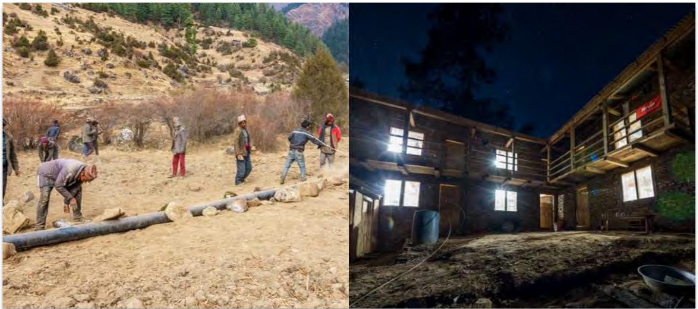
Abb. 3: Bauarbeiten und Maschinenhaus des 6.6 kW Kleinstwasserkraftwerks in Mohari (© RIDS-Schweizland)
