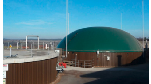
Das landwirtschaftliche Biogas wird in der Anlage in Uttewil (Bösingen) seit 1979 verwertet. Quelle: Marcel Gutschner
