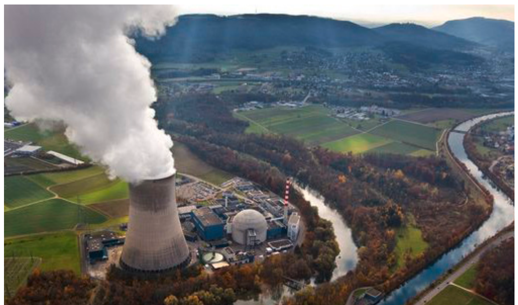
Kernkraftwerk Gösgen (SO)
