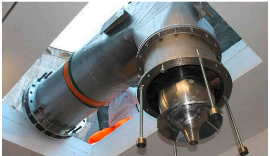
Bau des neuen Dotierkraftwerks Montsalvens, das mit einer Diagonalturbine mit einer Leistung von 211 kW ausgestattet wird. Quelle: Groupe E/EnergieSchweiz, Newsletter Nr. 24 Kleinwasserkraftwerke, 2014
