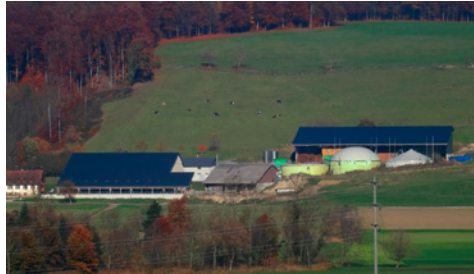
Biogasanlage in Seedorf (Noréaz) mit einer elektrischen Leistung von 295 kW. Quelle: Marcel Gutschner
