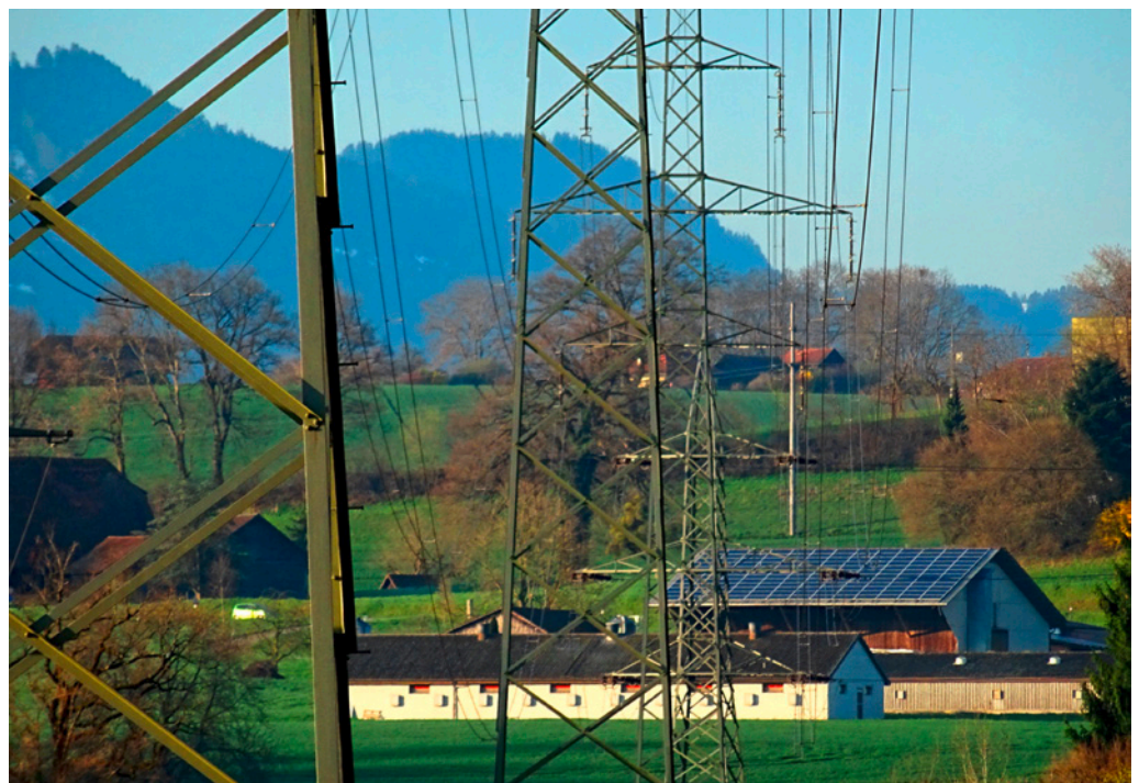
Das künftige Stromversorgungssystem muss die Zunahme der Stromerzeugung aus erneuerbaren Quellen berücksichtigen und sich auf ein intelligentes Netz abstützen, das für die dezentrale Stromproduktion gerüstet ist. Im Bild: Bauernhof in Römerswil (St. Ursen). Quelle: Marcel Gutschner
