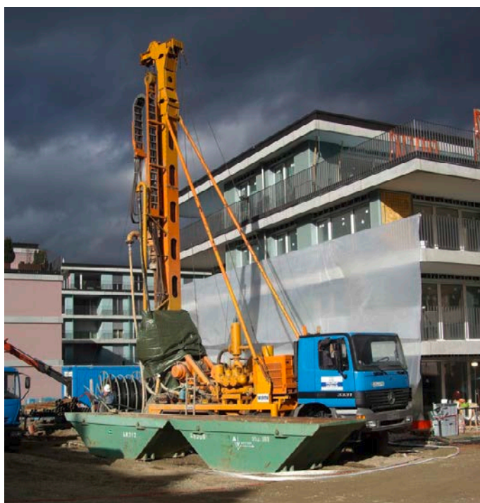
Bohrung für eine Erdwärmesonde. Quelle: GEOTHERMIE.CH
