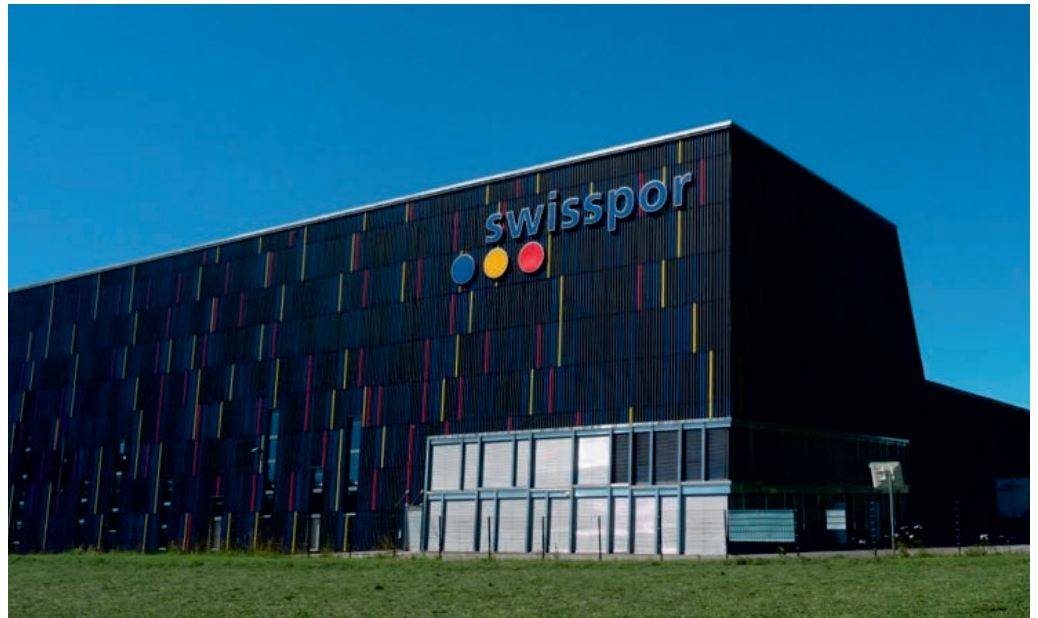
Der Produktionsbereich und die Verwaltungsräume dieses Gebäudes in Châtel-St-Denis werden durch Abwärme aus den Herstellungsprozessen geheizt. Quelle: Marcel Gutschner
