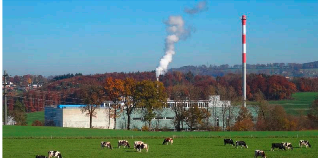
Kehrichtverbrennungsanlage der SAIDF. Quelle: Marcel Gutschnerr
