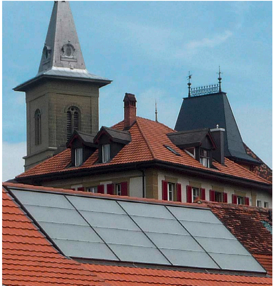
Verglaste Flachkollektoren in Belfaux. Quelle: Marcel Gutschner
